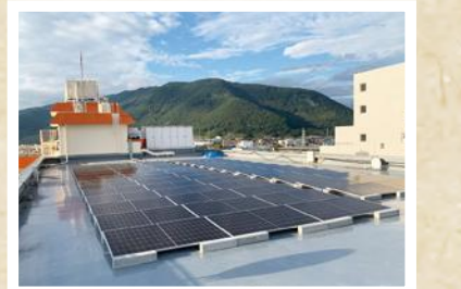
太陽光パネル設置
