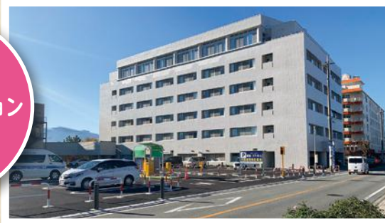
新駐車場整備
