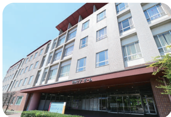
在宅支援センター甲州ケア・ホーム
